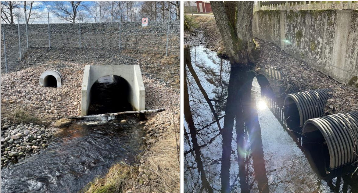
Figur 7. Vänster bild: Kulvertar under järnväg. Höger bild: Kulvertar under gångväg. Bildkälla: Sweco
